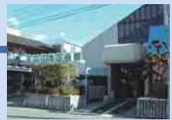
立花南生涯学習プラザ (旧立花地区会館)
