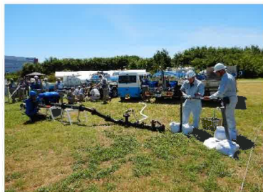
<水道施設復旧訓練>
