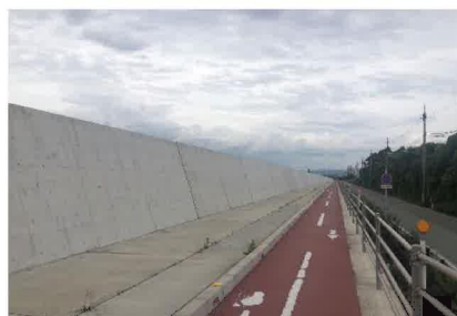
<丸島（武庫川防潮堤嵩上げ）>
