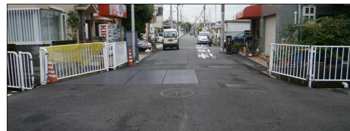
応急措置状況
