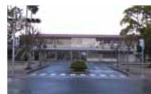
老朽化した管理棟
