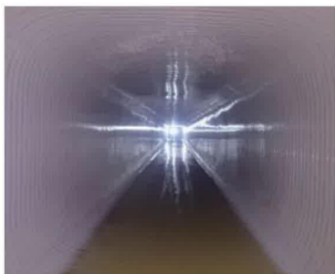
補強・リニューアルを行った下水道管
