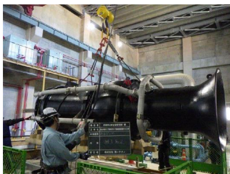
雨水ポンプ更新工事(栗山中継ポンプ場)
