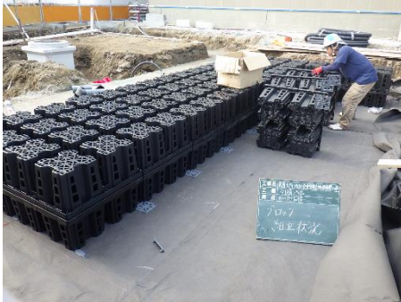
公共施設での雨水貯留浸透施設(武庫西生涯学習プラザ)
