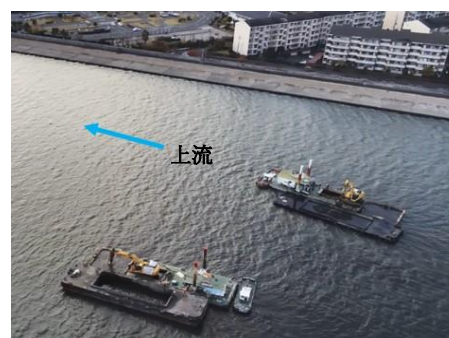
河床掘削工事(武庫川)
