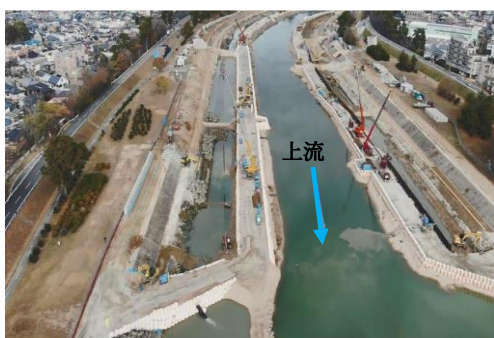
低水護岸工事(武庫川)
