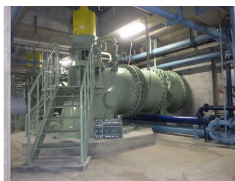
雨水ポンプ更新工事(栗山中継ポンプ場)
