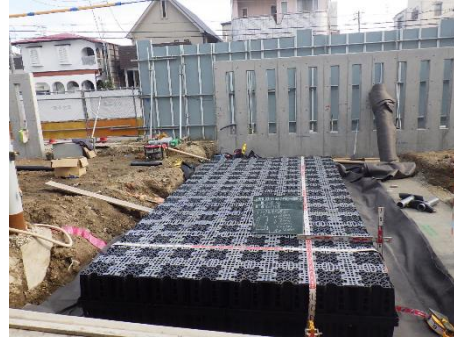
公共施設での雨水貯留浸透施設(武庫西生涯学習プラザ)
