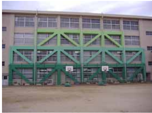
ピタコラム工法（下坂部小学校）
