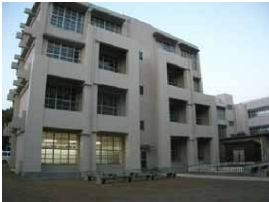
PCアウトフレーム工法（武庫南小学校）
