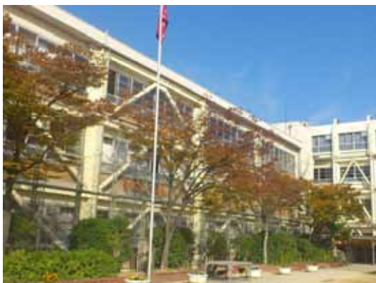
K Tブレース工法（大成中学校）
