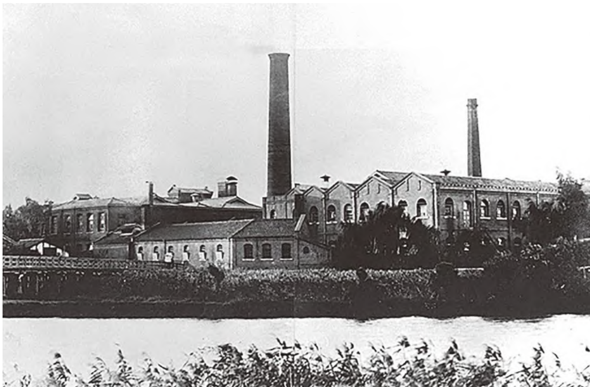
尼崎紡績本社工場
