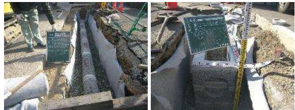
雨水浸透管・雨水浸透ますの設置
