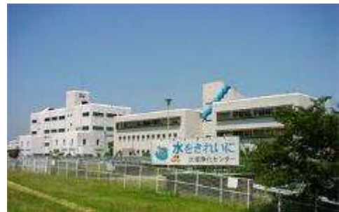
北部浄化センター
