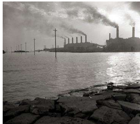
末広町、地盤沈下により道路が海に沈み、電信柱だけが水面に残っている。（昭和 29 年（1954）、村井邦夫氏撮影）
