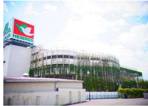
商業施設における建築物緑化
