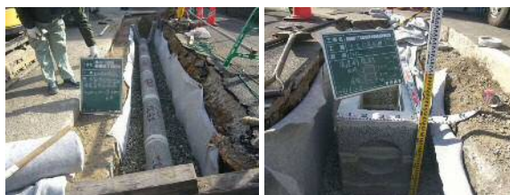
雨水浸透管・雨水浸透ますの設置
