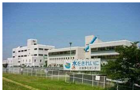
北部浄化センター
