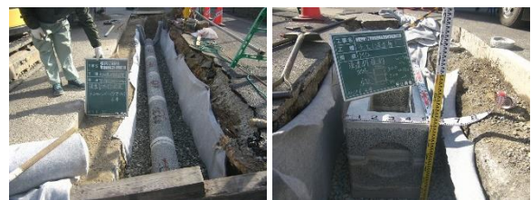
雨水浸透管・雨水浸透ますの設置
