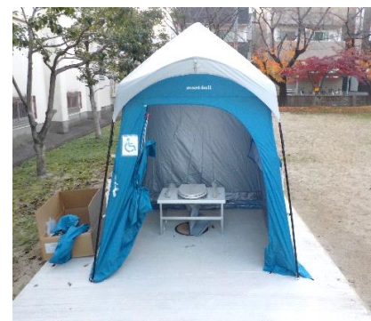
マンホールトイレ
