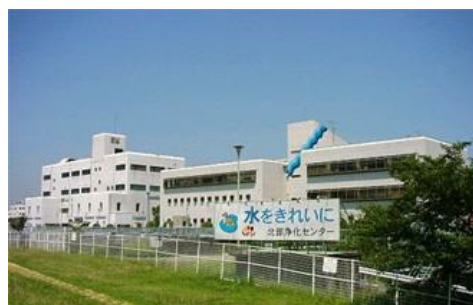
北部浄化センター
