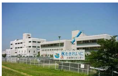
北部浄化センター
