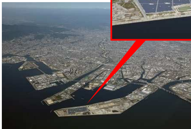
エコひょうご尼崎発電所
