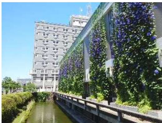
本庁舎南館の壁面緑化
