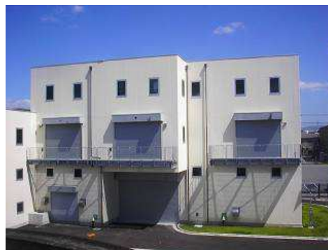
汚泥脱水施設
