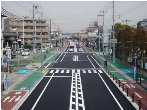
自転車道（車道の両端の部分）
