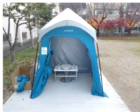
マンホールトイレ
