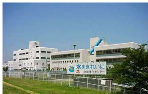
北部浄化センター
