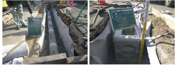
雨水浸透管・雨水浸透ますの設置
