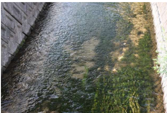
写真11 六樋取水口付近水路の水の様子（平成22年）
