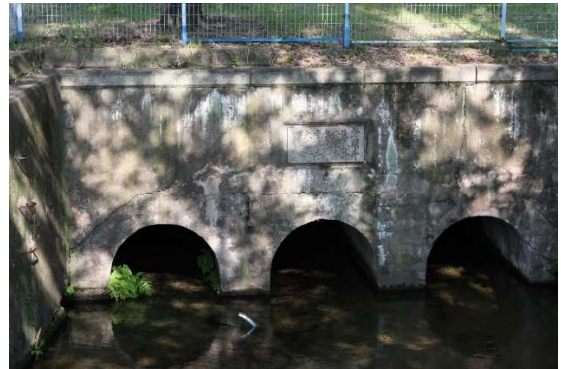
写真10 六樋取水口（平成22年） （武庫川の川底でろ過された水が流れ込む）
