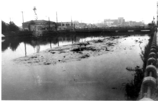
写真1 庄下川（昭和42年頃国道2号付近） 尼崎市立地域研究史料館蔵
