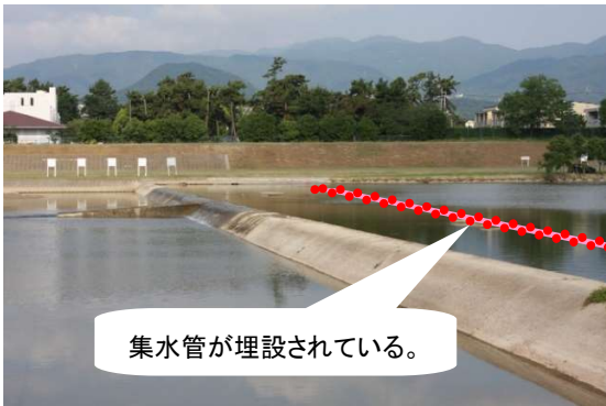
写真9 武庫川（六樋集水管埋設付近）（平成22年）
