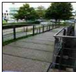
校舎側のスロープ
