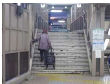
図 4.27 バリアフリー化未整備箇所（立花陸橋）
