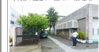
写真⑦：配送車 搬入口（西北門）
