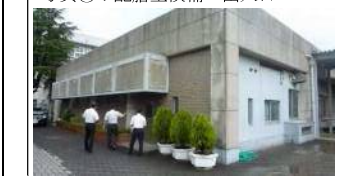
写真④：配膳室候補 出入口
