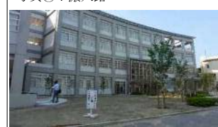
写真⑨：搬入路
