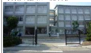
写真⑧：搬入口（南中門）
