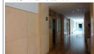
写真⑥：配膳室候補 出入口
