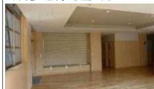
写真⑤：給食室候補 出入口
