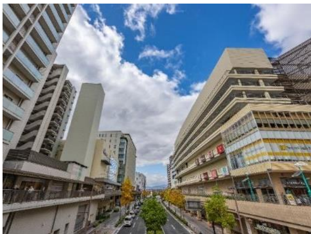
JR尼崎駅北側の整備
