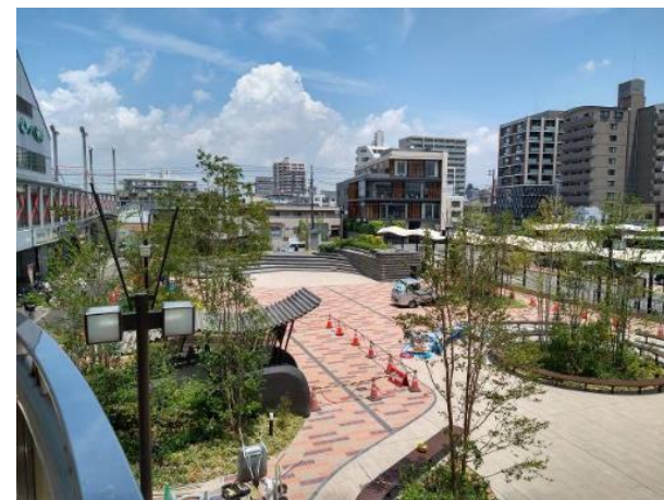
阪神出屋敷駅北側の改修
