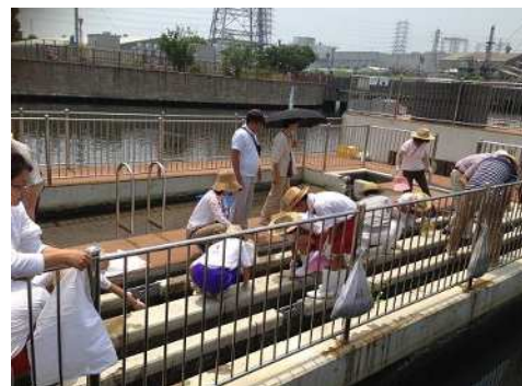
水質浄化施設
