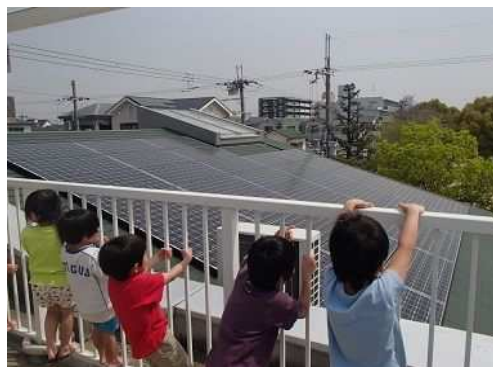
太陽光発電設備の設置事例 ポッポ保育園
