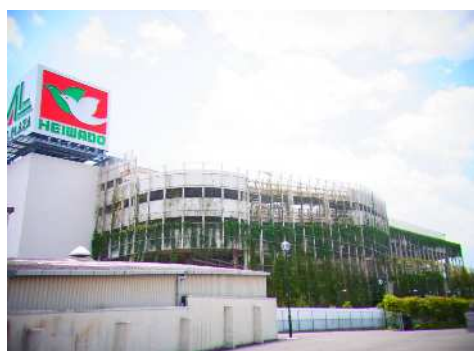
商業施設における建築物緑化
