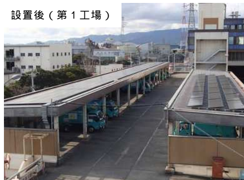
太陽光発電設備設置の過程
