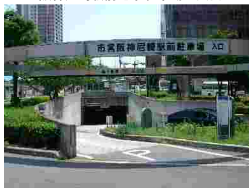
阪神尼崎駅前地下駐車場 入口
