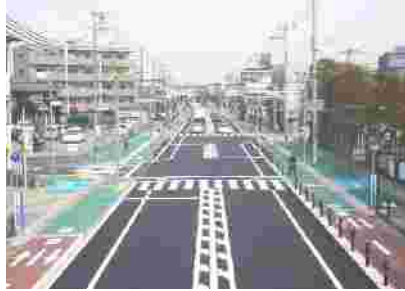
自転車道（神崎橋伊丹線）
