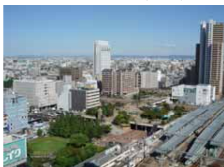
阪神尼崎駅周辺(北側)
