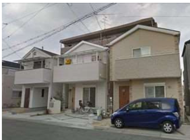
写真③（敷地面積約 80 m 2 、2 階建て）
