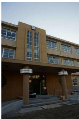
歴史博物館正面玄関部分 (工事中)
