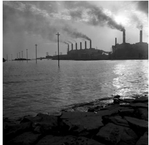
【図 地盤沈下の様子（末広町 道路が海に沈み、電信柱だけが水面上に残る）】
