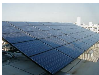
杭瀬小学校屋上
