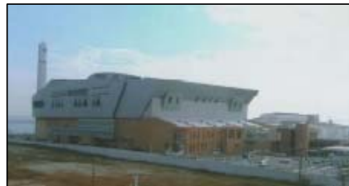
クリーンセンター第2工場
