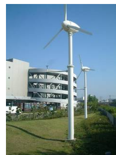
風力発電設備
