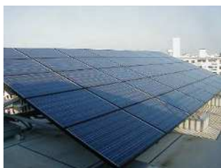
杭瀬小学校屋上
