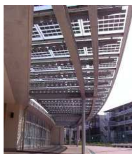
成良中学校校舎庇
