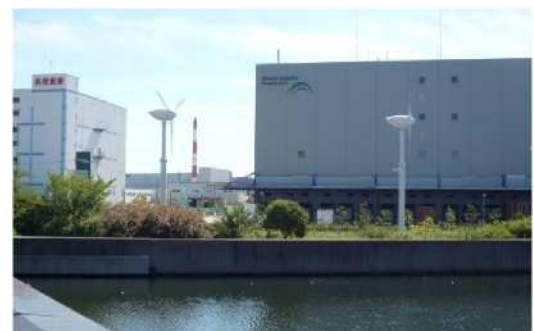
風力発電施設
