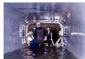
管きょ改築工事 (管更生工事)
