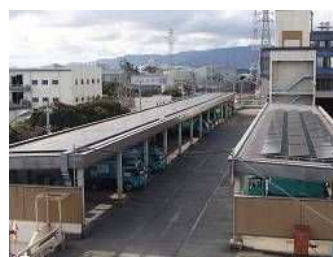
太陽光パネル
