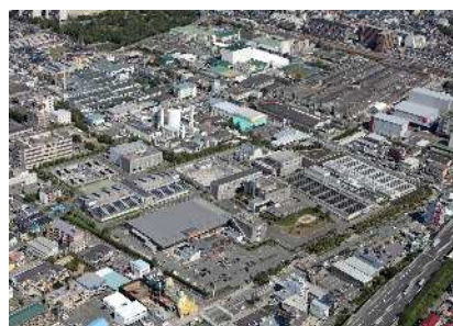
阪神水道企業団尼崎浄水場
