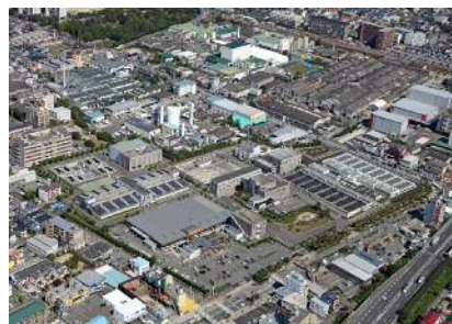
阪神水道企業団尼崎浄水場
