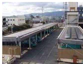
太陽光パネル
