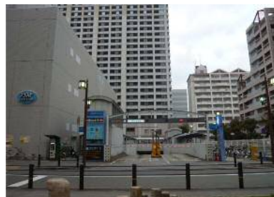
(第二地区駐車場)
