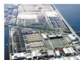
武庫川下流浄化センター
