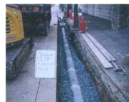
雨水浸透管建設工事
