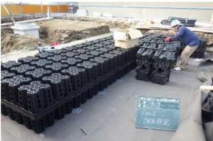
空隙率の大きいプラスチック製雨水貯留浸透ブロックを芝生広場の地下部分に設置
