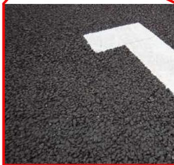
空隙率の大きい舗装により水を通しやすくし、雨水を舗装面にためず地中に浸透させる舗装
