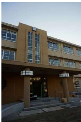
歴史博物館正面玄関部分 (工事中)
