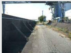
防潮堤（尼崎港）
