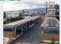
クリーンセンター太陽光発電所 →
