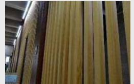
兵庫県産ひのきを 活用した縦格子
