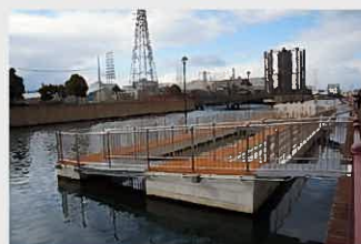
↓ 尼崎運河の水質浄化施設
