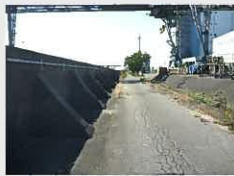
防潮堤（尼崎港）
