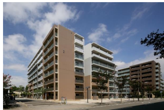
公民連携による建替団地(市営時友住宅)
