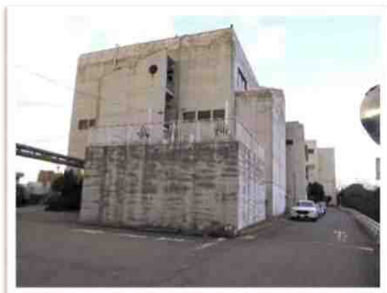
【北部浄化センター管理棟 外壁塗装の施工前】
