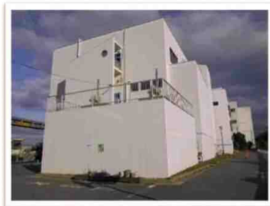
【北部浄化センター管理棟 外壁塗装の施工後】
