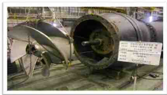
【雨水ポンプ設備の整備前】
