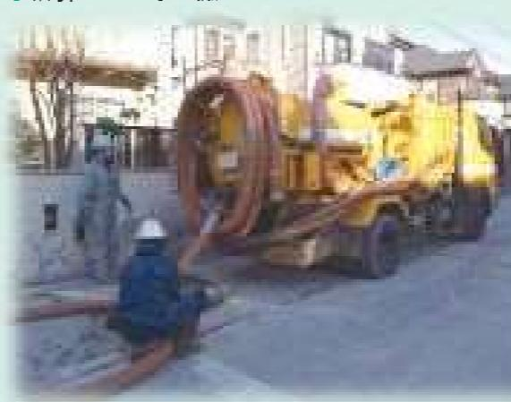
下水管が破損し下水が流せなくなった場合は、仮の排水路を整備したり、マンホール内にポンプを設置することにより、下水を被災していない管路へ流すことができます。
