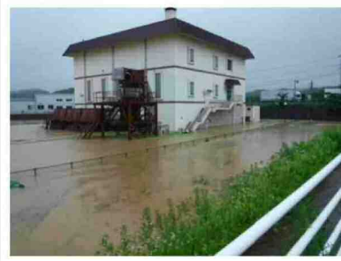
広島県三原市：本郷第一・第二ポンプ場
