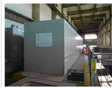
電気設備を高所へ移設
