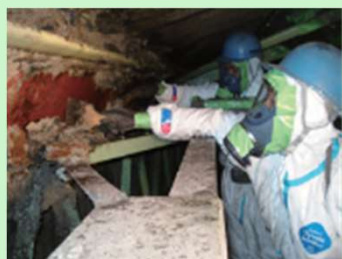
吹付け石綿の除去作業の様子
