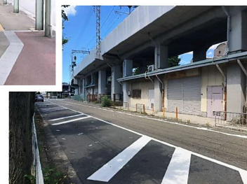
公園北側道路（現況）
