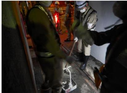
鉄扉のレールの砂を除去します
