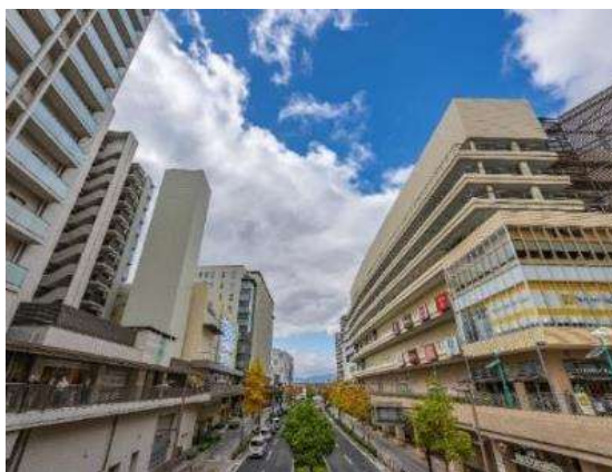
JR尼崎駅北側の整備
