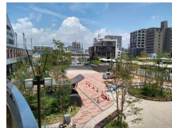
阪神出屋敷駅北側の改修
