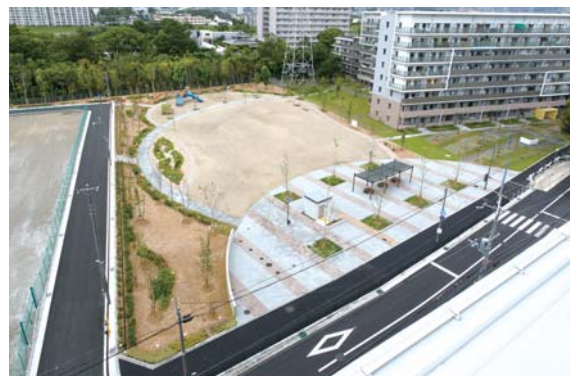
防災機能を有する公園(宮の北公園) (マンホールトイレや雨水流出抑制機能)
