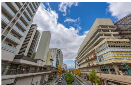
JR尼崎駅北側の整備
